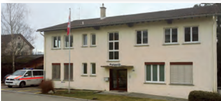
Der neue Polizeiposten an der Stelzenstrasse 42 in Meilen.
