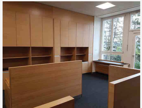
Praxisausbau in Zürich
