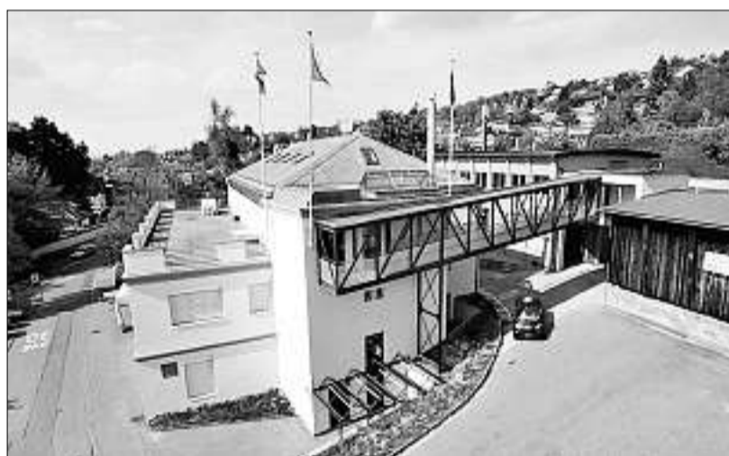
Sitz der Gemi an der Mariahaldenstrasse 1. Im Hintergrund das 2007 sanierte Gebäude mit den neuen Ausstellungsräumen. (zvg)
